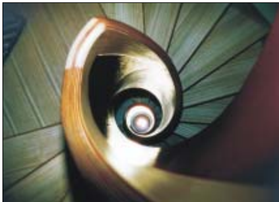
Escalera construida con peldaños de tablero contrachapado de eucalipto. Fotografía: José María Ramos
