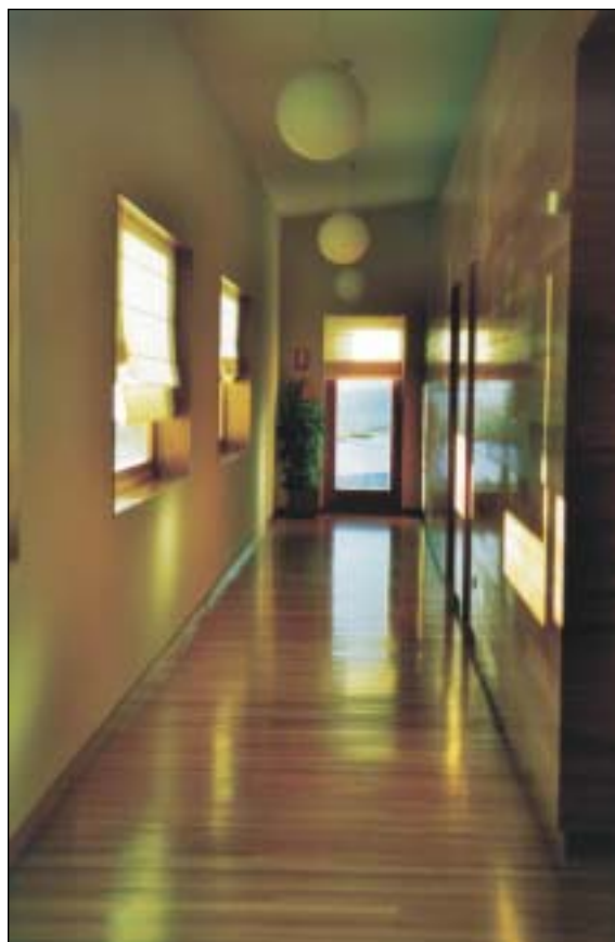
Entarimado de eucalipto en el edificio del CIS-Madera. Fotografía: Manuel Touza
