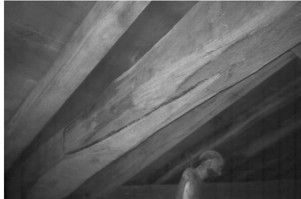
Unión oblicua vertical, 2 planos de encolado. Par de cubierta reparado.
