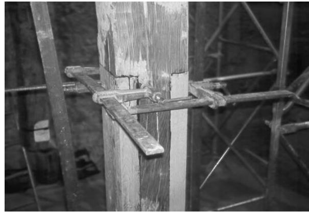
Reparación de pilar. Catedral de Santa María. Vitoria-Gasteiz. Encolado.
