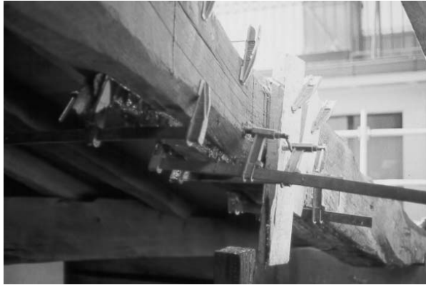
Unión oblicua vertical, 2 planos de encolado. Par de cubierta encolando.
